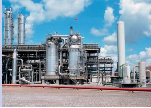
MegaMethanol Plant, Trinidad
